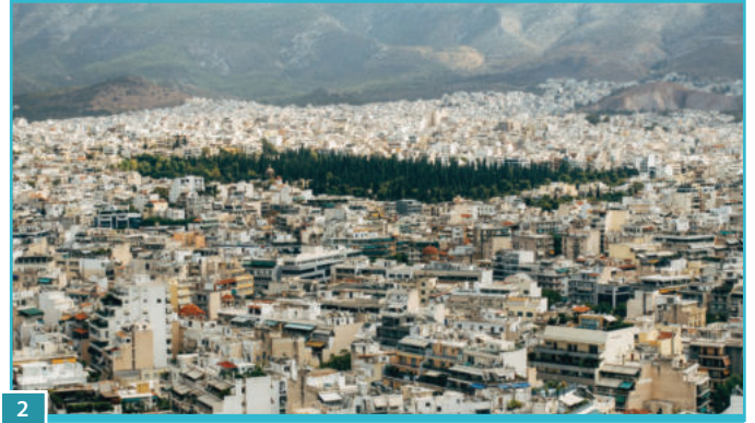
2 Οι δυσκολίες λήψης ικανοποιητικού σήματος παραμένουν και σε χαμηλούς ορόφους αστικών περιοχών με πυκνή δόμηση.
